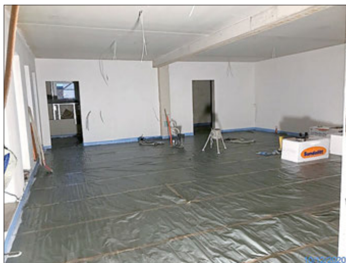
Neubau Feuerwehrgerätehaus Treffurt
