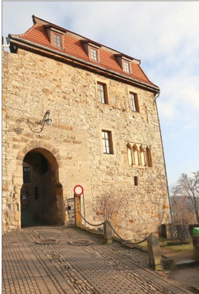
Blick auf das Westtor der Creuzburg. Tor und Burg stammen aus der Zeit der Ludowinger Landgrafen. Archäologische Grabungen würden sicher den Nachweis einer älteren fränkischen Anlage erbringen.
