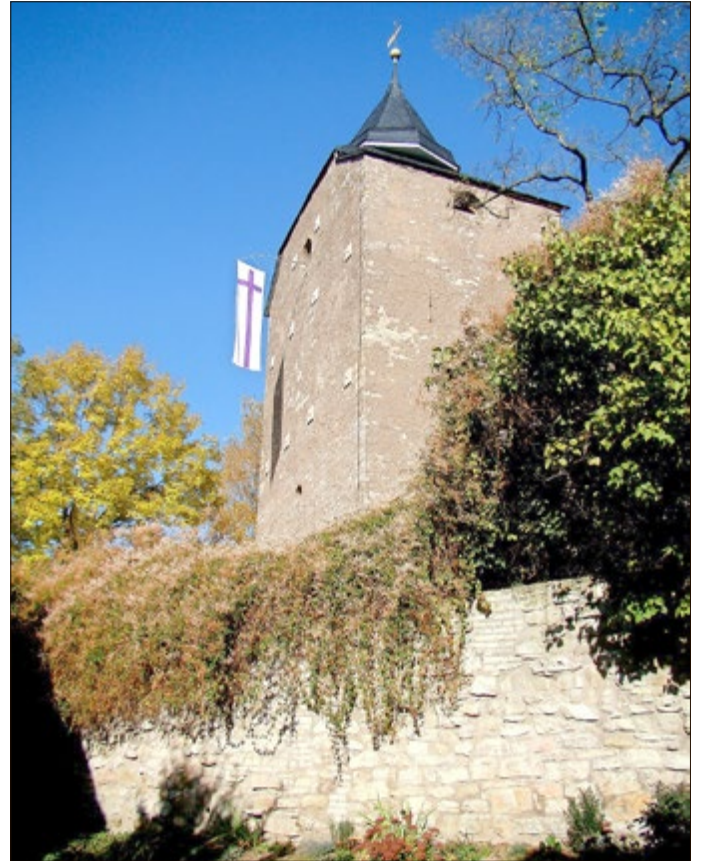
Keimzelle des germanischen Ortes Mihla dürfte die St. Martinskirche über dem Ort mit ihren uralten starken Befestigungsmauern sein. Alle Fotos Verfasser
