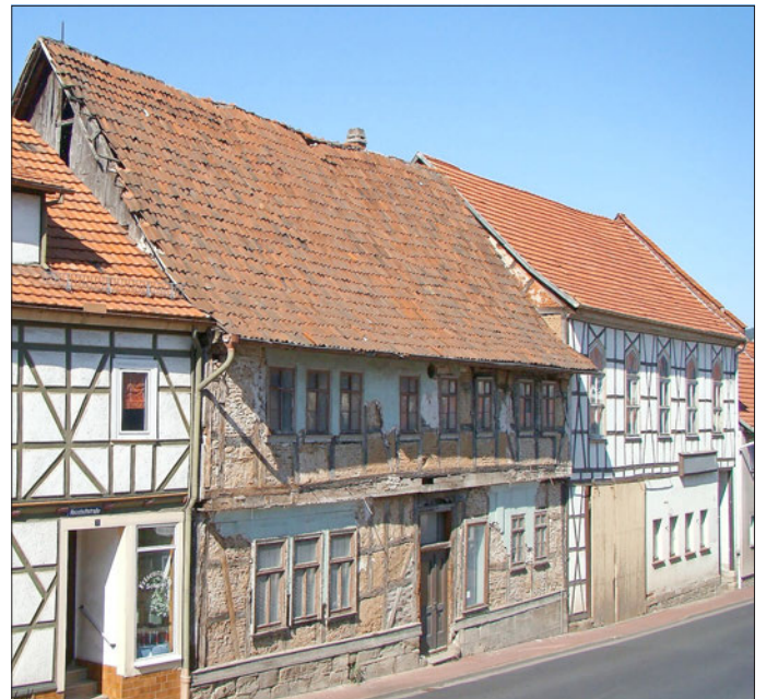
Der Gasthof „Zum Mohren“ kurz vor dem Abriss
