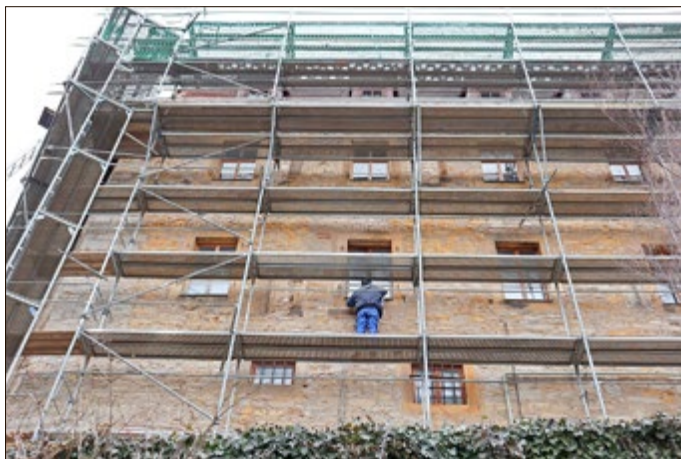
Männer des Creuzburger Bauhofes arbeiten an den Fenstern der Burg.
