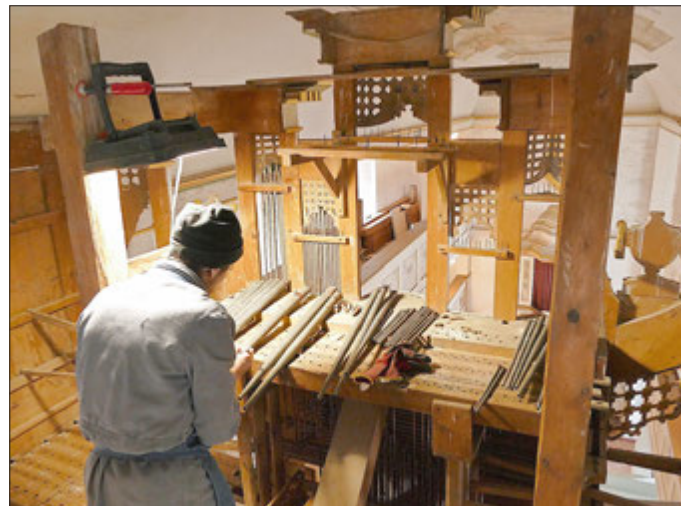
Ausbau und Beschriften der Metallpfeifen des Oberwerks
