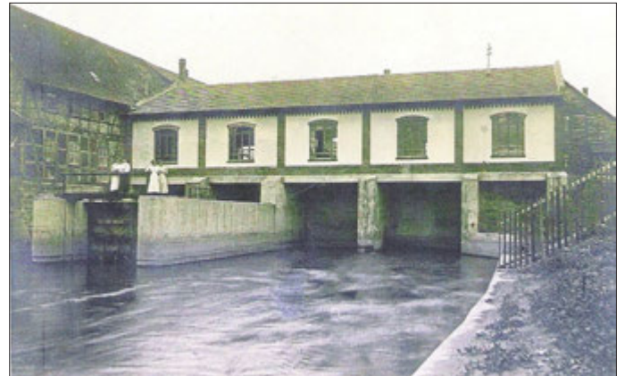
Die Mihlaer Werramühle nach ihrem Umbau zum Wasserkraftwerk. Vorhanden auch eine Schleusenanlage für den Verkehr der Holzflöße und anderer Wasserfahrzeuge.
