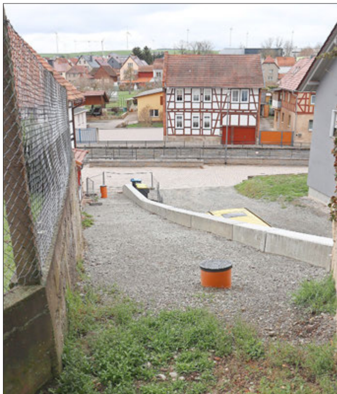
An einem stadt-eigenen Grundstück in Scherbda, dem Standort des früheren Feuerwehrhauses, wird durch den Bauhof am Hang eine Mauer zur Absicherung der Gefällefläche errichtet.
