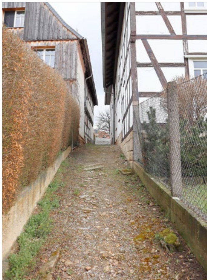
Blick auf den oberen Teil der Badergasse. Die für den Sommer geplanten Bauarbeiten müssen wegen mangelnder Beteiligung von Baufirmen verschoben werden.
