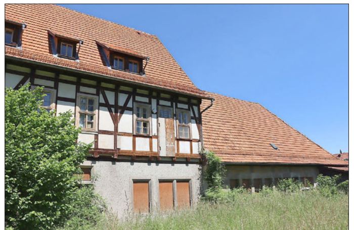
Spuren des zunehmenden Verfalls nach beinahe 15 Jahren des Leerstandes sind nicht mehr zu übersehen.
