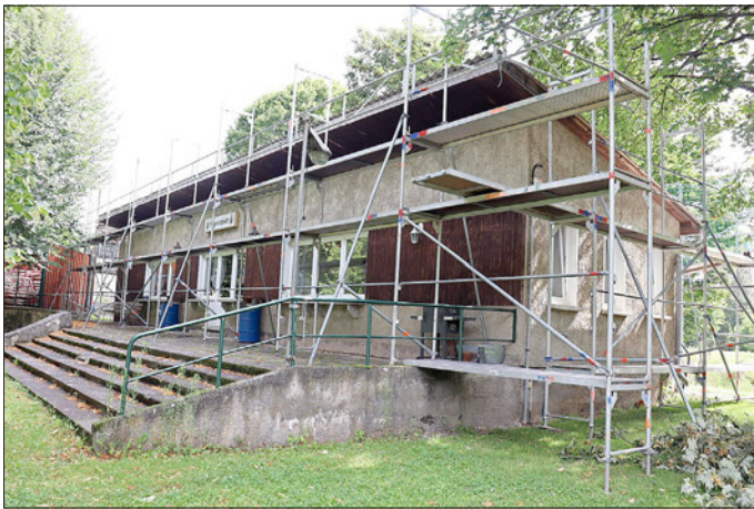
Die Ebenshäuser Angerschenke ist eingerüstet, die Dacharbeiten beginnen.
