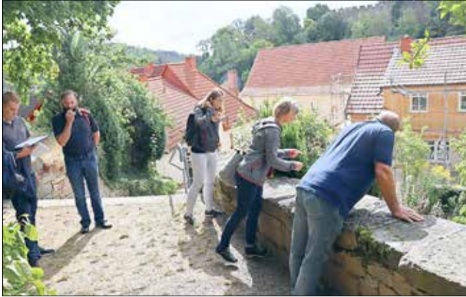
Bei der Besichtigung der Treppenanlage zur Creuzburger Gottesackerkirche.
