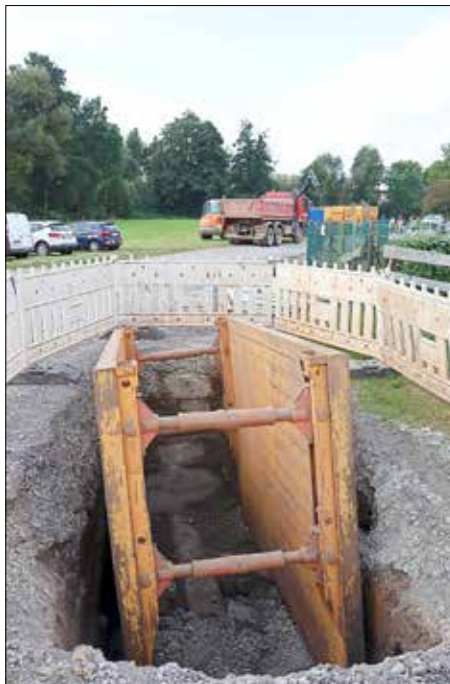
Der Kanalbau beginnt an der Sandmühle.
