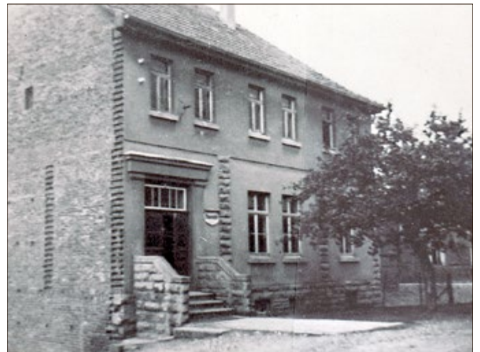
Neues Schulhaus in der Lindenstraße, erbaut 1926 im Auftrag der Gemeinde Scherbda. 1958 wurde durch den Ausbau des Dachgeschosses eine zweite Wohnung geschaffen. Nach Ende des Schulbetriebes 1970 waren hier der Kindergarten und später die „Dorfschänke“ untergebracht. Künftig soll das Gebäude zum „Multifunktionshaus“ umgebaut werden.
