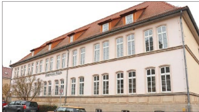
Viel Geld wird ab dem Haushalt 2022 in den Umbau der Creuzburger Praetoriusschule als Verwaltungssitz fließen.
