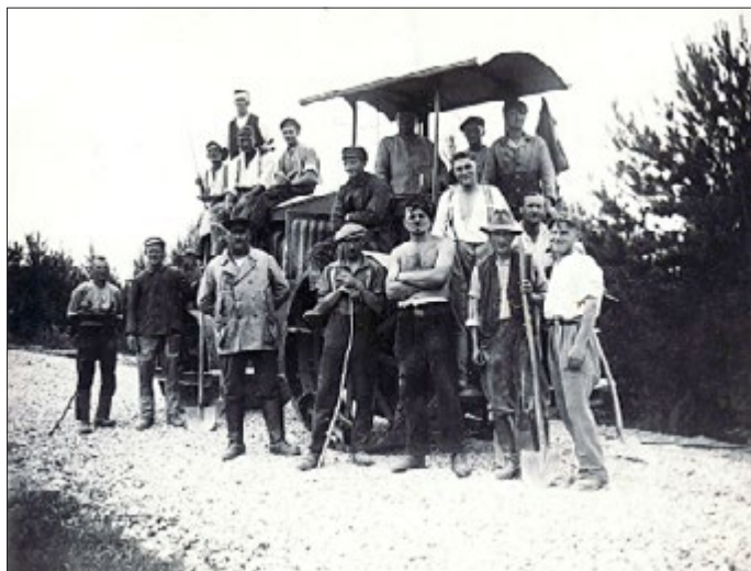
Straßenbaukolonne beim Wegebau zwischen Creuzburg und Scherbda.
