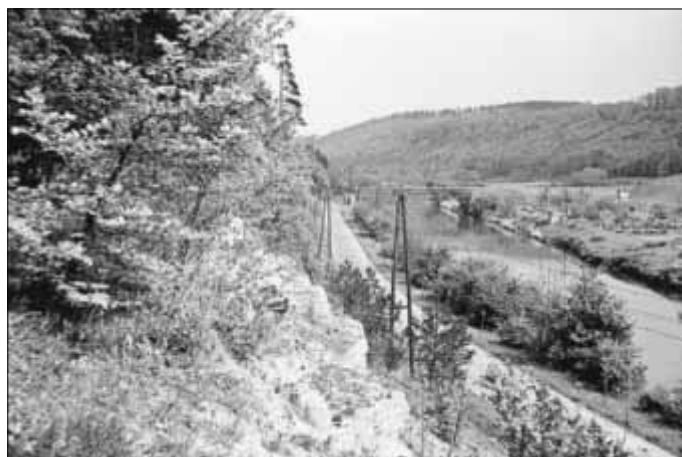
Aufnahme vom gleichen Standort auf die Landstraße nach Mihla und die zweite Rohrbrücke. Rechts das Pumpengehäuse für einen der dortigen Klärteiche.
