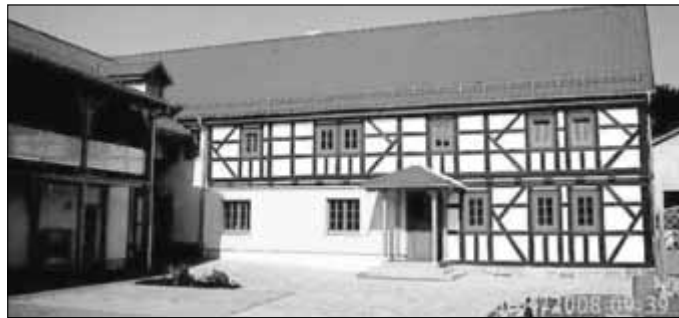
Das denkmalgeschützte Fachwerkhause ist das Kerngebäude des Dorfzentrums.
