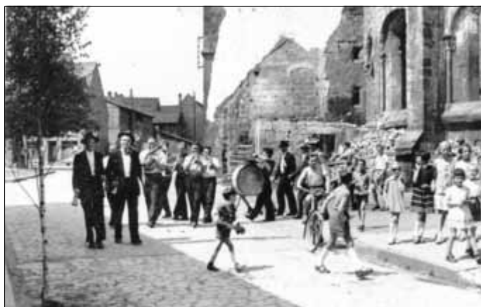
An der zerstörten Nikolaikirche beim Umspielen
