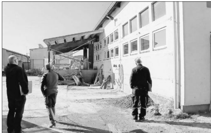
Handwerker und Planer bei einer Bauberatung an der bisher nicht gedämmten Südseite des Gebäudes.
