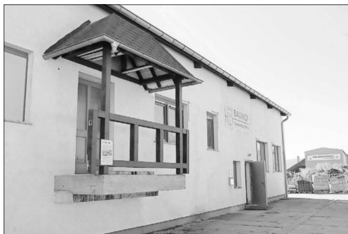
Das Mihlaer Bauhofgebäude soll nach den modernsten Standards energetisch saniert werden. Das Referenzobjekt des Landes wird mit europäischen Fördermitteln umgesetzt.
