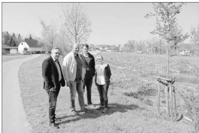
Die Mitarbeiterin Frau Holz des LVA mit ihren Prüfkollegen am 3. Bauabschnitt der Lautersanierung in Mihla.
