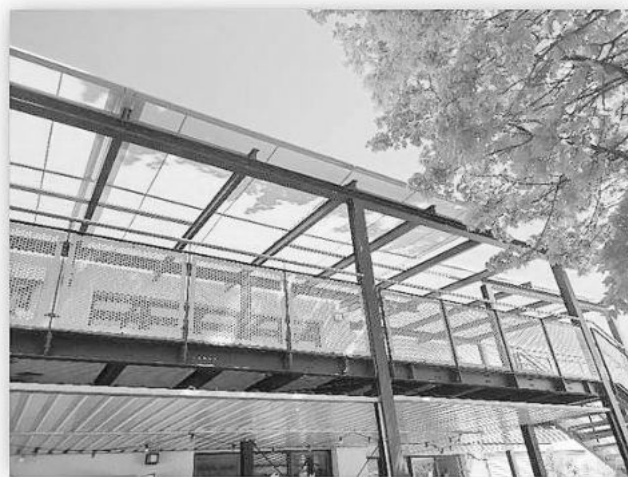
Die Sonnenabdeckung im Einsatz.
