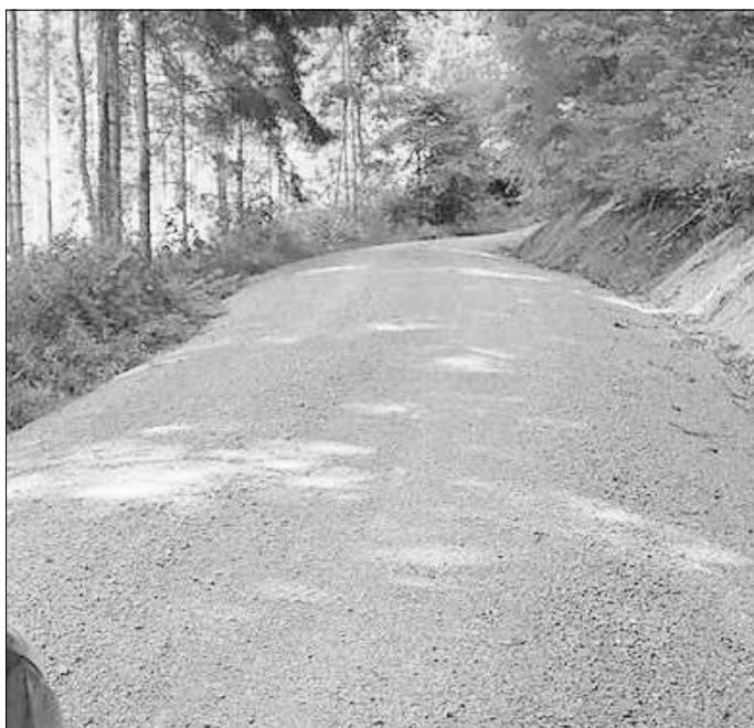
Vorbildlich saniert wurde der Weg „Im Segel“ im Auftrag der Kommune
