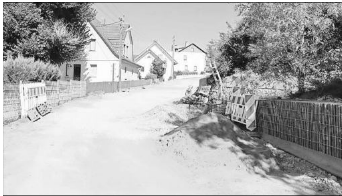
In diesem Abschnitt wurden die Trinkwasseranschlüsse verlegt Amt Creuzburg
