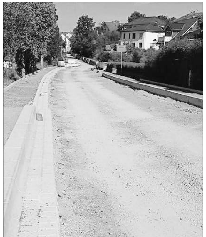
Die Bordanlage ist fertig, links am Bildrand eine der beiden neuen Bushaltestellen
