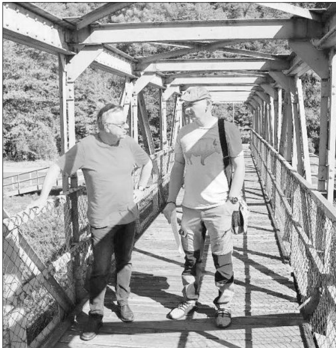
Denkmalbehörde, Bauabteilung und Bürgermeister bei der Besichtigung der Buchenauer Brücke.
