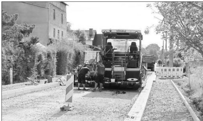
Die Bitumendecke wird „gefahren“
