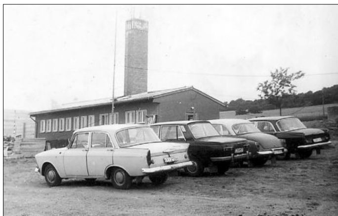
Fuhrpark während der Abnahme des 1. Bauabschnittes der Bullenmastanlage. Im Hintergrund ist das neue Sozialgebäude zu sehen[23]
