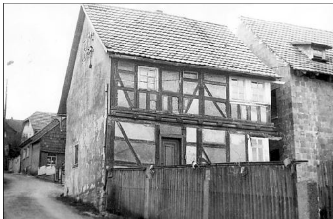
Wohnhaus Thomas-Müntzer-Straße Nr. 4 kurz vor dem Abbruch, rechts ist bereits der heutige Neubau zu sehen. Die damalige Engstelle der Straße wurde beseitigt[5]
