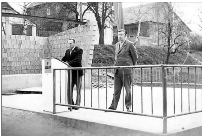
Ansprache zum 1. Mai 1976 auf dem Festplatz in der Lindenstraße. Hinter der neuen Tanzfläche ist die in Bau befindliche Festbühne zu sehen[13]
