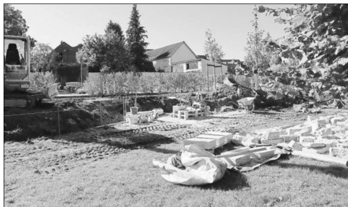
Als Abgrenzung zum unteren Friedhofbereich wird eine Natursteinmauer mit Treppe errichtet
