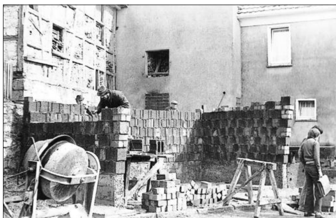
Das in Bau befindliche Buswartehäuschen, 1979
