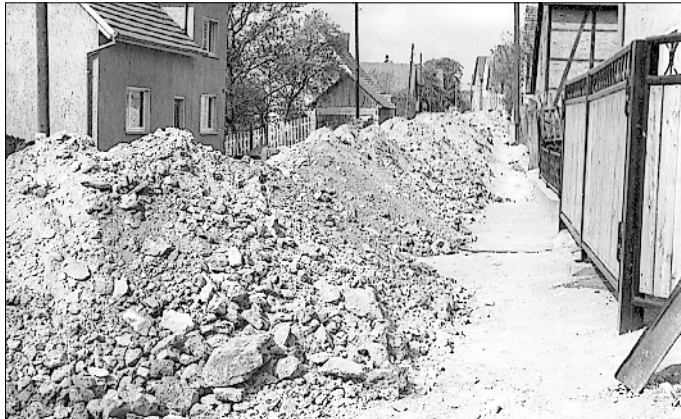
Tiefbauarbeiten in der Lindenstraße
