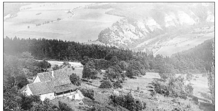
Blick über Eschenborn hinein ins Werratal. Gut zu sehen die Ebenauer Eisenbahnbrücke. Das Foto entstand also lange nach 1907, der Eröffnung der Strecke. Ein großer Teil der früheren Nebengebäude in Eschenborn steht schon nicht mehr.
