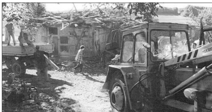
Beim Abbruch der Pfarrscheune im September 1997
