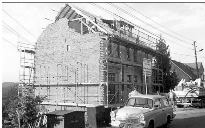
Umbauarbeiten im Rahmen der Dorferneuerung am Objekt Lindenstraße 24, September 1997. Im Vordergrund ist der kommunale „Trabant 601 Universal“ zu sehen
