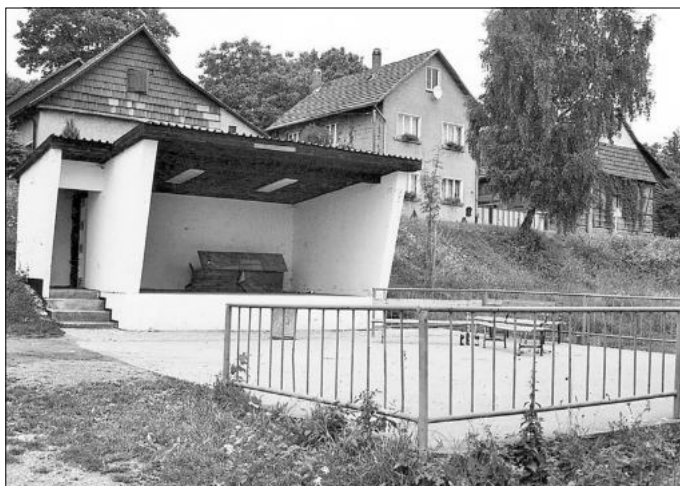
Diese aus den 1970-er Jahren stammende Anlage auf dem Festplatz wurde im Oktober 2009 abgebrochen.
