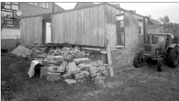
Holzbaracke in der Angerstraße 10 während des Abbruches im Juni 2018[8].
