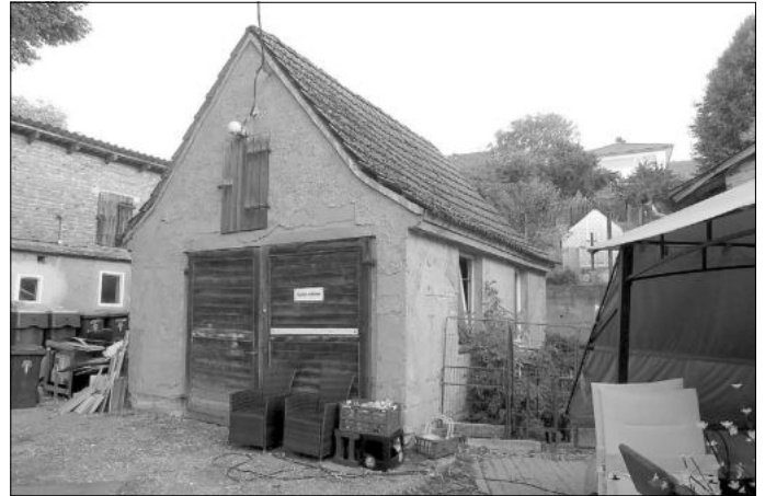
Das alte Spritzenhaus in der Angerstraße wenige Wochen vor dem Abbruch.
