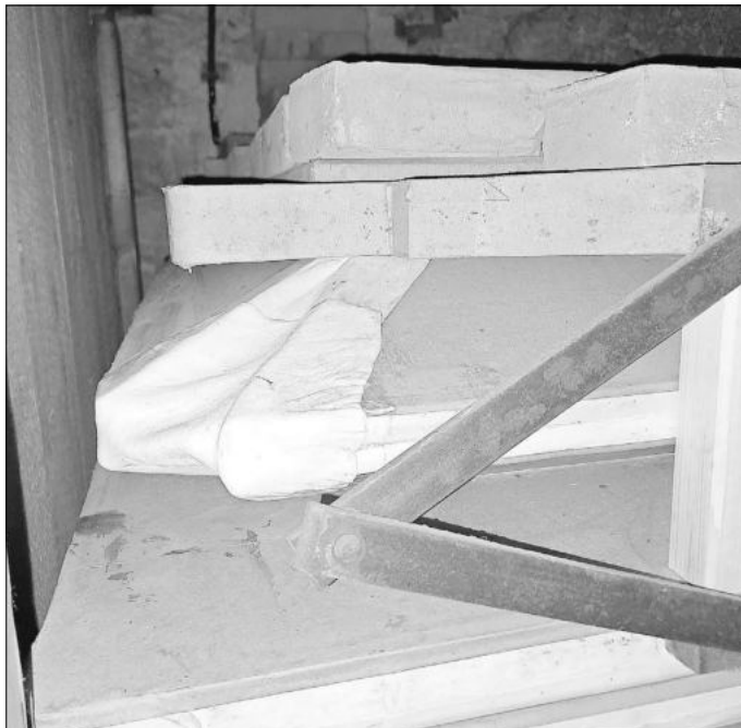
Die defekte Stelle am Balg wurde mit Leder repariert.
