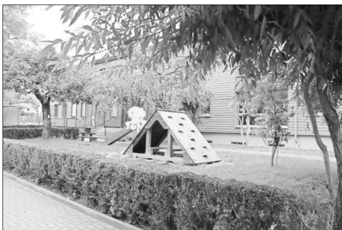
Während der Umbauzeit immer in Nutzung: Haus 1 der Kita.
