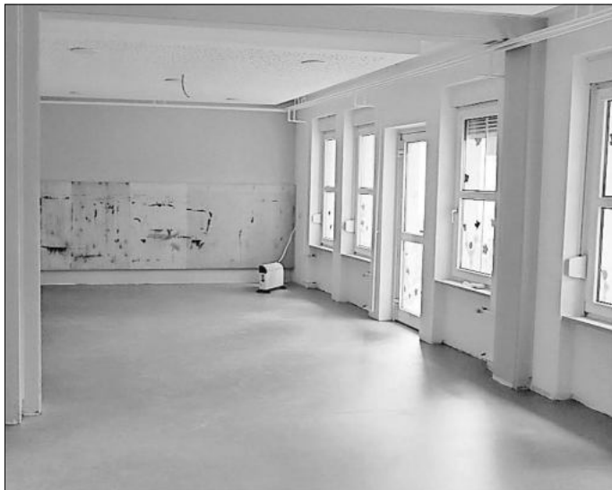
Einer der sanierten Gruppenräume im Haus 2.
