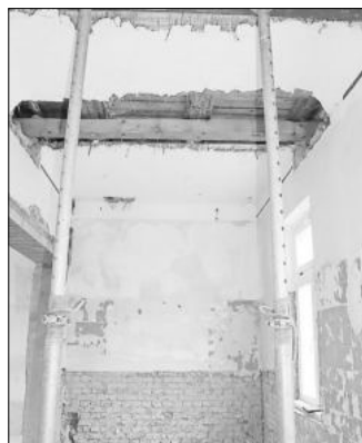
Tragende Balken mussten ersetzt werden.
