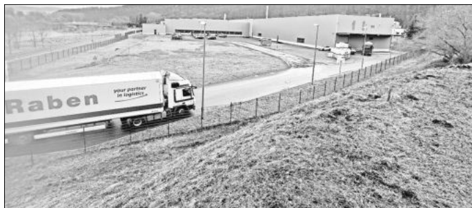
Die Firma ATP in Buchenau beginnt nach der Zustimmung im Stadtrat demnächst mit der Errichtung eines dritten Betriebsteiles in der Baulücke.
