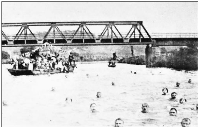
Die „Werraschwimmfahrt“ 1925 unterwegs in Richtung Mihlaer Werrabad. Gerade ist die Mihlaer Eisenbahnbrücke erreicht. Auf den begleitenden geschmückten Kähnen herrscht großer Betrieb.
