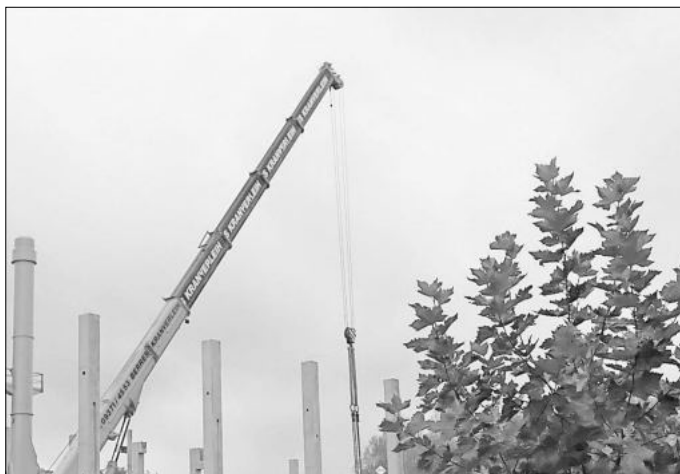
Bei ATP in Buchenau wächst die neue Produktionshalle empor.
