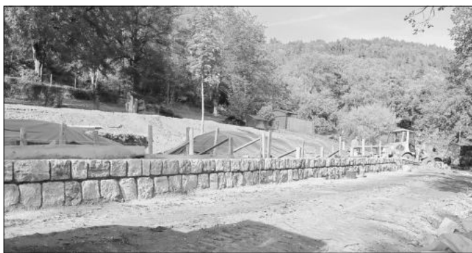
Blick auf das Baugeschehen auf dem Creuzburger Friedhof.
