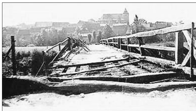
Die „Separationsbrücke“ über Mühlgraben der Werra im Zustand um 1930, wenige Jahre vor dem Abriss.
