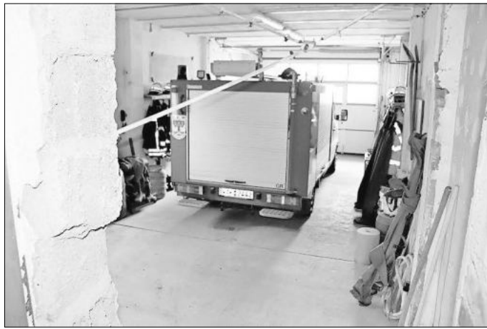
Bestandteil der diesjährigen Bauarbeiten am Feuerwehrgerätehaus ist auch die Neustrukturierung der Räumlichkeiten. Besonders wichtig ist dabei die Vergrößerung der Garagenanlage für das Feuerwehrauto.
