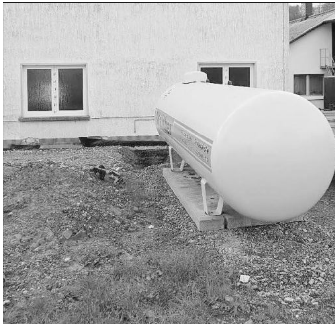
Der Gastank als Voraussetzung für die neue Heizungsanlage steht bereits und soll nun angeschlossen werden.
