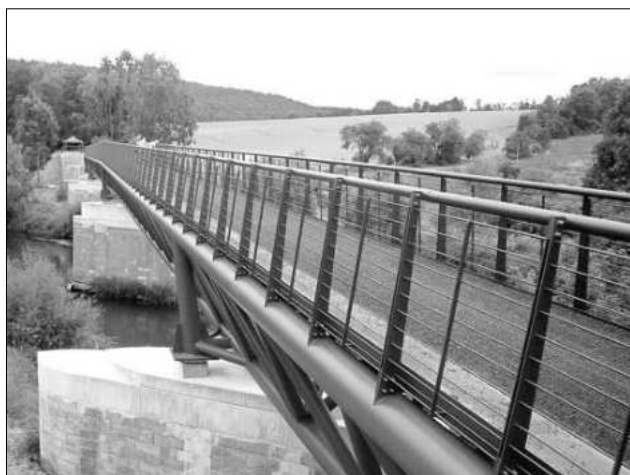
Blick über die Werraradbrücke bei Ebenau Foto: Autor
