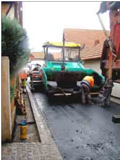
Die Tragschicht steht, nun wird die Deckschicht eingebaut.
