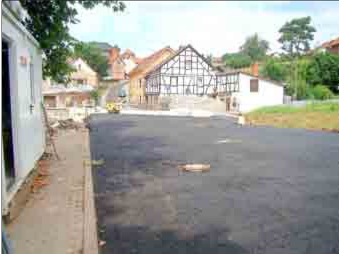
Die Tragschicht in Bitumen ist auf der Brückenrampe und auf der Brücke angebracht.
