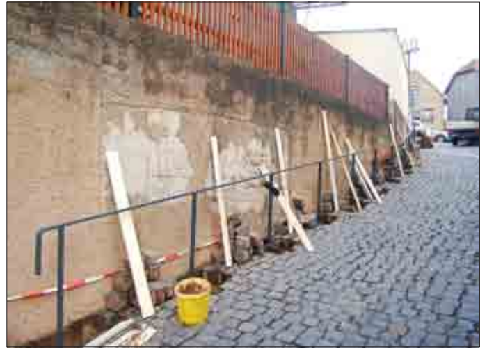
Das Geländer am Ölberg wird errichtet.
