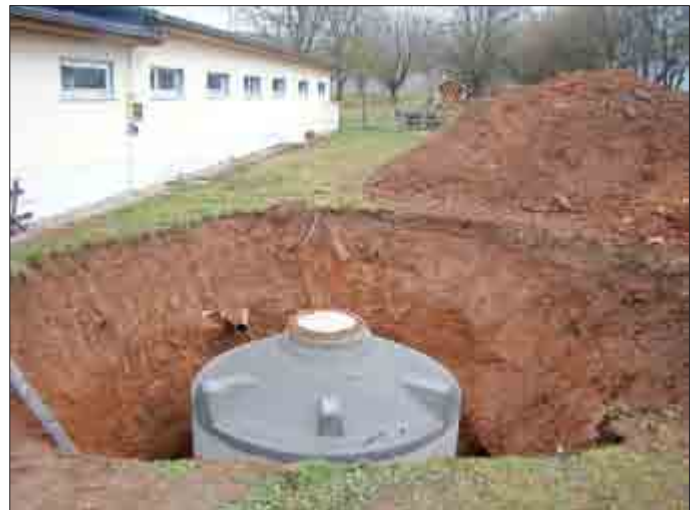
Das Foto machen die Ausmaße der neuen Kläranlage im Freibad deutlich.
